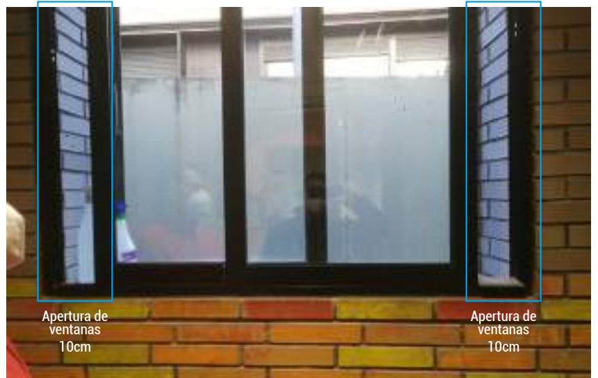
Foto 3: Aperturas de 10 cm cada hoja de las ventanas del pasillo de infantil.
